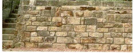
Nach eineinhalb Jahren ist unsere Stützmauer am Kirchbrink in Hilligsfeld fertig. Als Stützung wurde eine Betonmauer angelegt. Die alten Sandsteine, die während der Bauphase eingelagert waren, wurden als Mauer vor die Betonwand gesetzt. Nun erstrahlt sie mit alten Steinen wieder im neuen Glanz.
